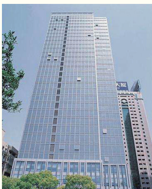
上海京二法人入居ビル
